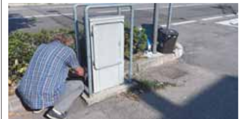
Posa di esche in via Scuderlando
